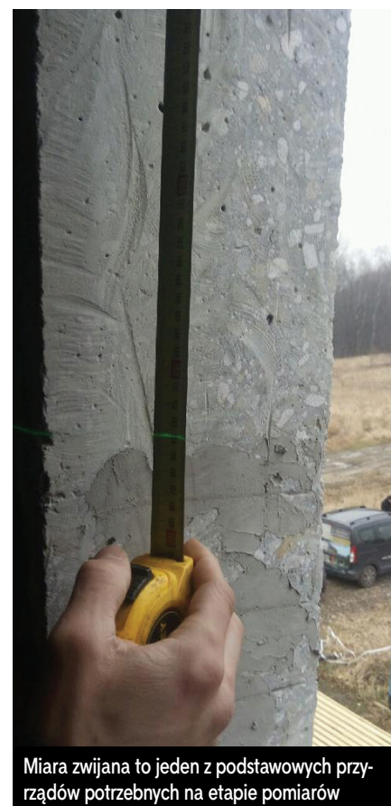
Pierwsze wizyty na budowie służą skontrolowaniu przygotowania otworów, sprawdzeniu warunków na budowie, dostępu do poszczególnych otworów okiennych; dopiero później zaczynają się pomiary
