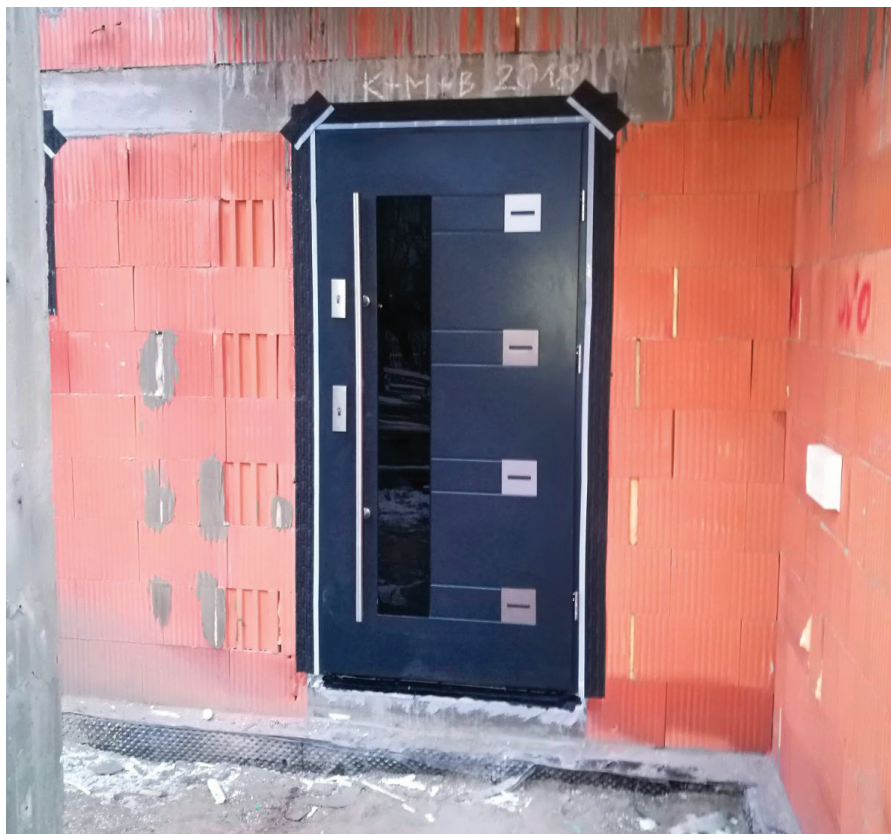
Jedynym słusznym sposobem montażu jest taki, gdzie złącze jest ciepłe i szczelne – naszym zadaniem jest przekonać klientów, by wybierali prawidłowy montaż
