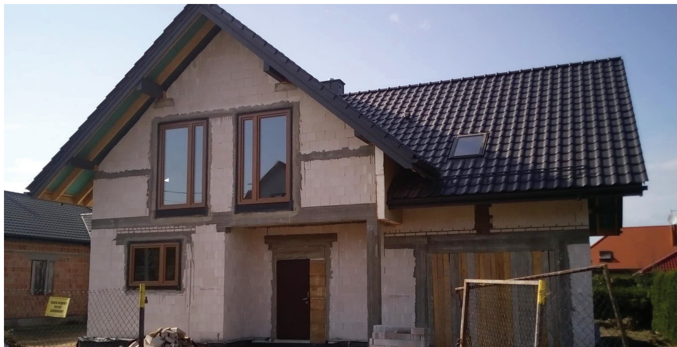
Często klienci montują drzwi po tzw. mokrych robotach, aby nie były narażone na uszkodzenia przez kolejne ekipy budowlane. Klienci wówczas mają zamontowane drzwi tymczasowe
