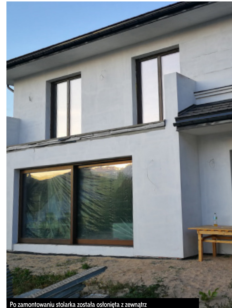
Po ustawieniu HS-a w otworze, konieczne było jego wypoziomowanie na podmurówce, ustawienie pionów, poziomów i przekątnych
