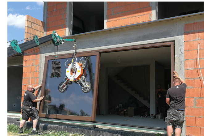
Po ustawieniu HS-a w otworze, konieczne było jego wypoziomowanie na podmurówce, ustawienie pionów, poziomów i przekątnych
