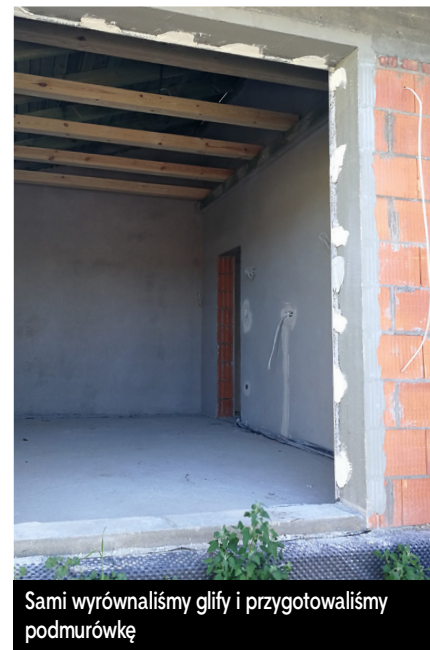
Przed rozpoczęciem montażu okien, w budynku zostały otynkowane wszystkie ściany wewnętrzne
