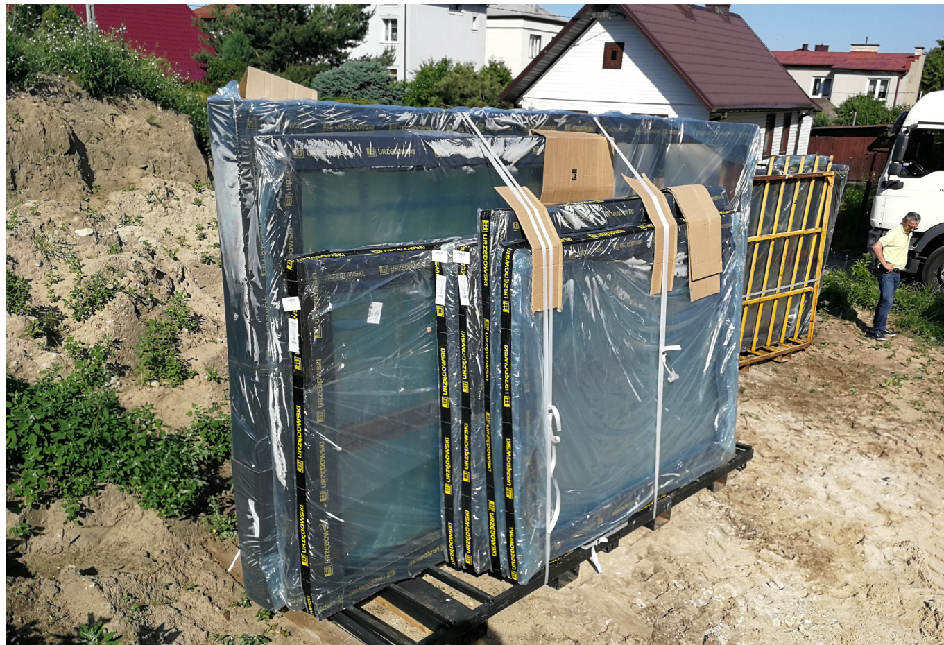
Do zamontowania mieliśmy 17 okien o łącznej wadze 2,5 tony
