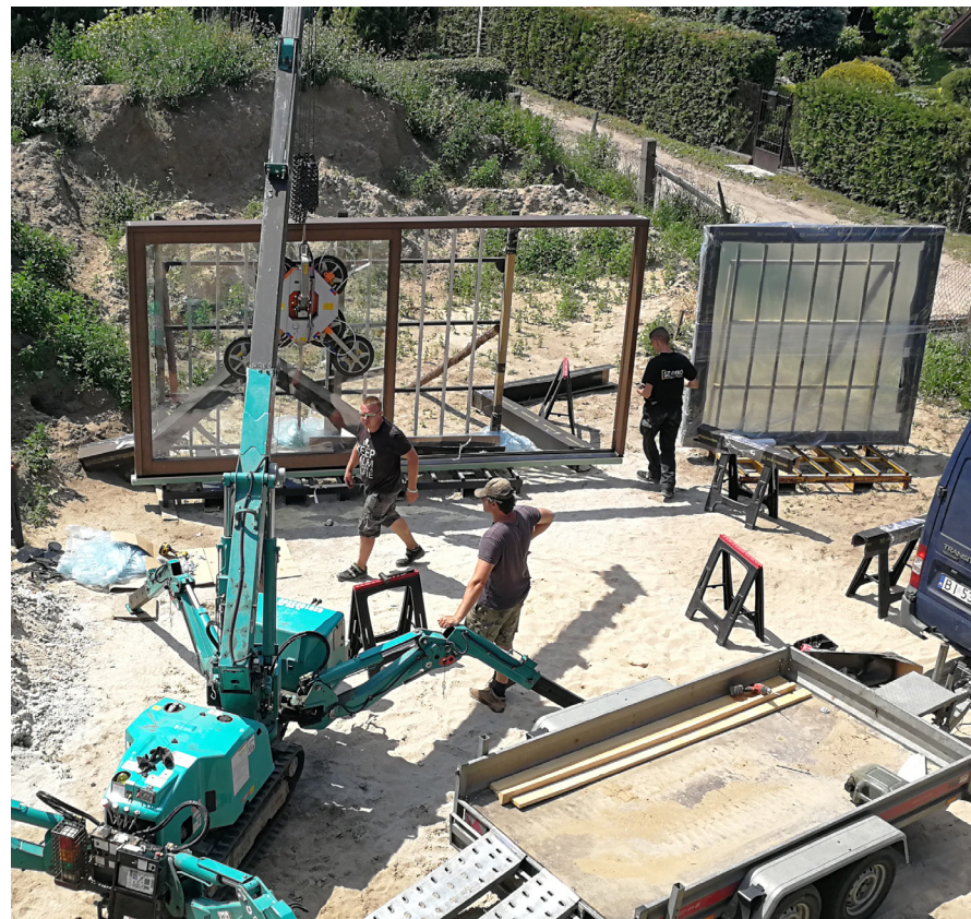
Przed montażem z balkonu HS zostało zdjęte skrzydło jezdne
