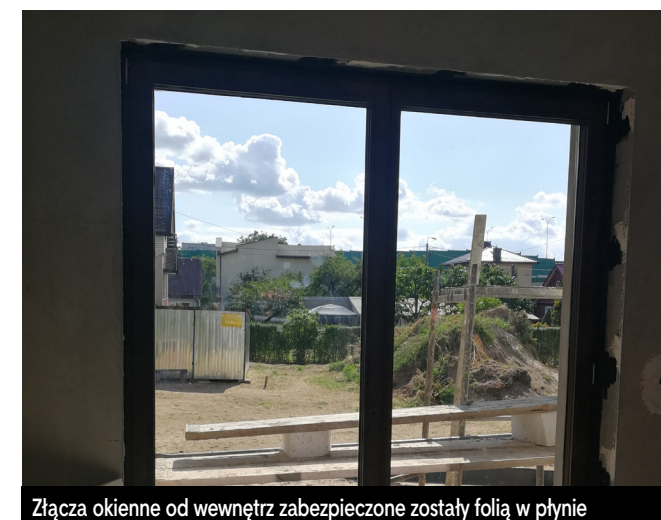
Po ustawieniu HS-a w otworze, konieczne było jego wypoziomowanie na podmurówce, ustawienie pionów, poziomów i przekątnych
