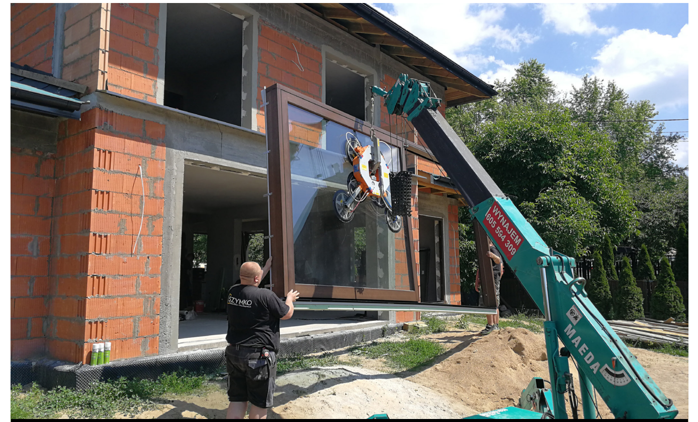
HS, „uzbrojony” w podwaliny, kotwy i folię okienną, podawany jest do otworu okiennego
