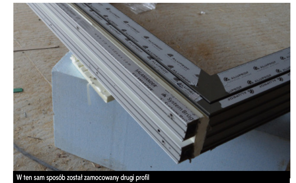
Poszerzenie z PVC zamocowane zostały do spodu podwaliny z XPS – najpierw na warstwę kleju...
