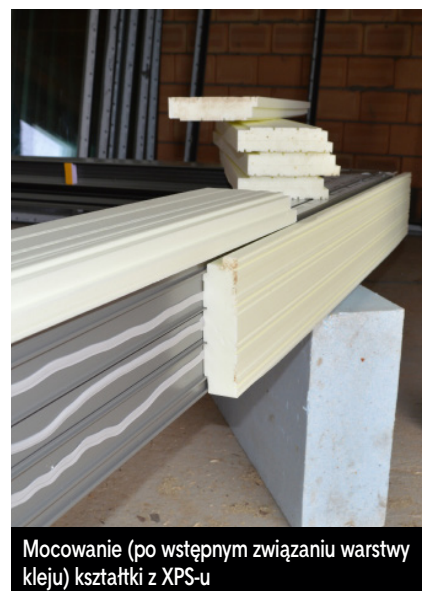
7-metrowa konstrukcja aluminiowego HS-a. Zanim zostanie wstawiona w otwór okienny, musi zostać odpowiednio przygotowana
