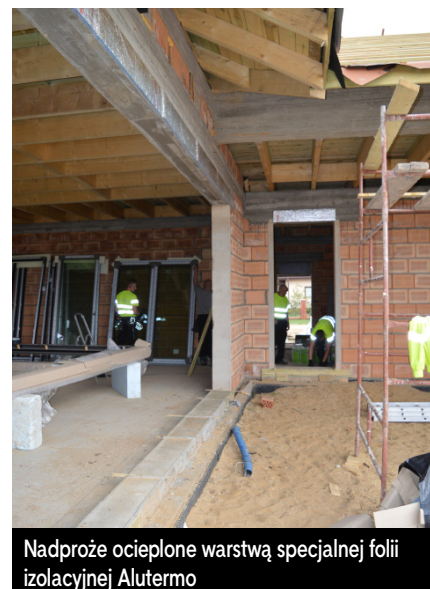
Kształtki z XPSU, umożliwiające łatwiejsze wywiniecie folii (w związku z zaizolowaniem nadproża folią, okna były wysunięte o 2 cm)
