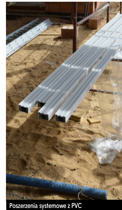
Poszerzenie z PVC zamocowane zostały do spodu podwaliny z XPS – najpierw na warstwę kleju...
