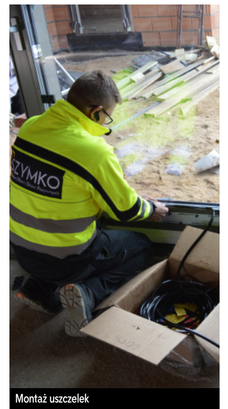
Stabilizowanie przeszklenia za pomocą klinów
