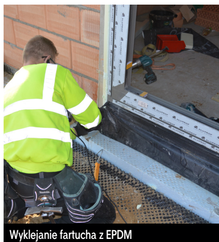
Kształtka XPS mocowana pod fartuchem
