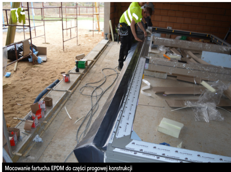
Przyklejanie folii paroizolacyjnych
