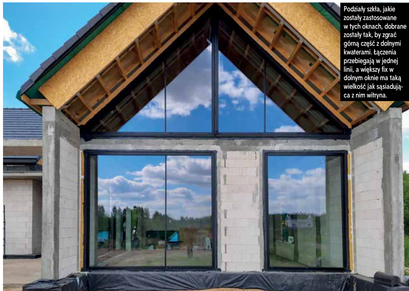
Do montażu tego okna została przygotowana specjalna rama w części dachu – uczestniczyliśmy w jej projektowaniu.
