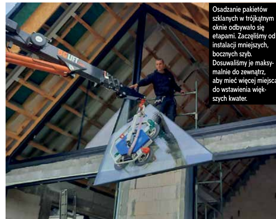
Poza omówionymi już oknami w szczycie i HSem mieliśmy do osadzenia system fasadowy w szczycie dachu (kalenicy). Była to chyba pierwsza tego typu realizacja, efekt jest fantastyczny. Bez pomocy manipulatora podanie szyb na tą wysokość byłoby niemożliwe.
