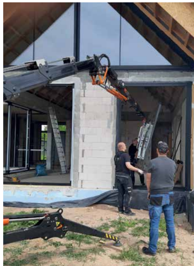
Podczas szklenia dużych konstrukcji okiennych konieczne było użycie manipulatora
