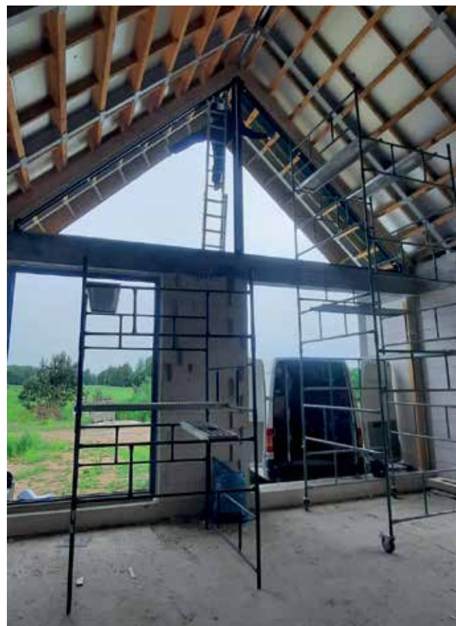
Do montażu tego okna została przygotowana specjalna rama w części dachu – uczestniczyliśmy w jej projektowaniu.
