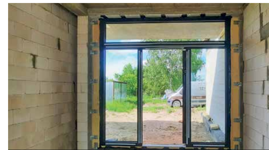
Drzwi wejściowe – przeszklenia wykonano z szyby hartowanej 6 mm.
