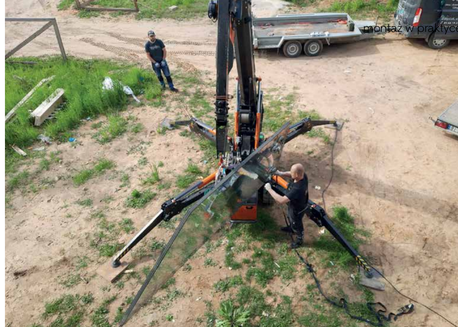
Poza omówionymi już oknami w szczycie i HSem mieliśmy do osadzenia system fasadowy w szczycie dachu (kalenicy). Była to chyba pierwsza tego typu realizacja, efekt jest fantastyczny. Bez pomocy manipulatora podanie szyb na tą wysokość byłoby niemożliwe.
