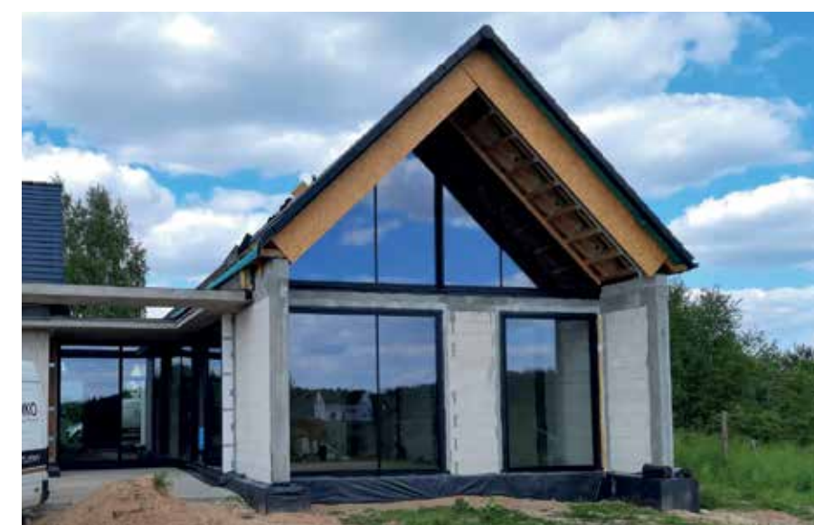
Pokaźne okno w kształcie trójkąta, zamontowane w ścianie szczytowej w części dziennej.
