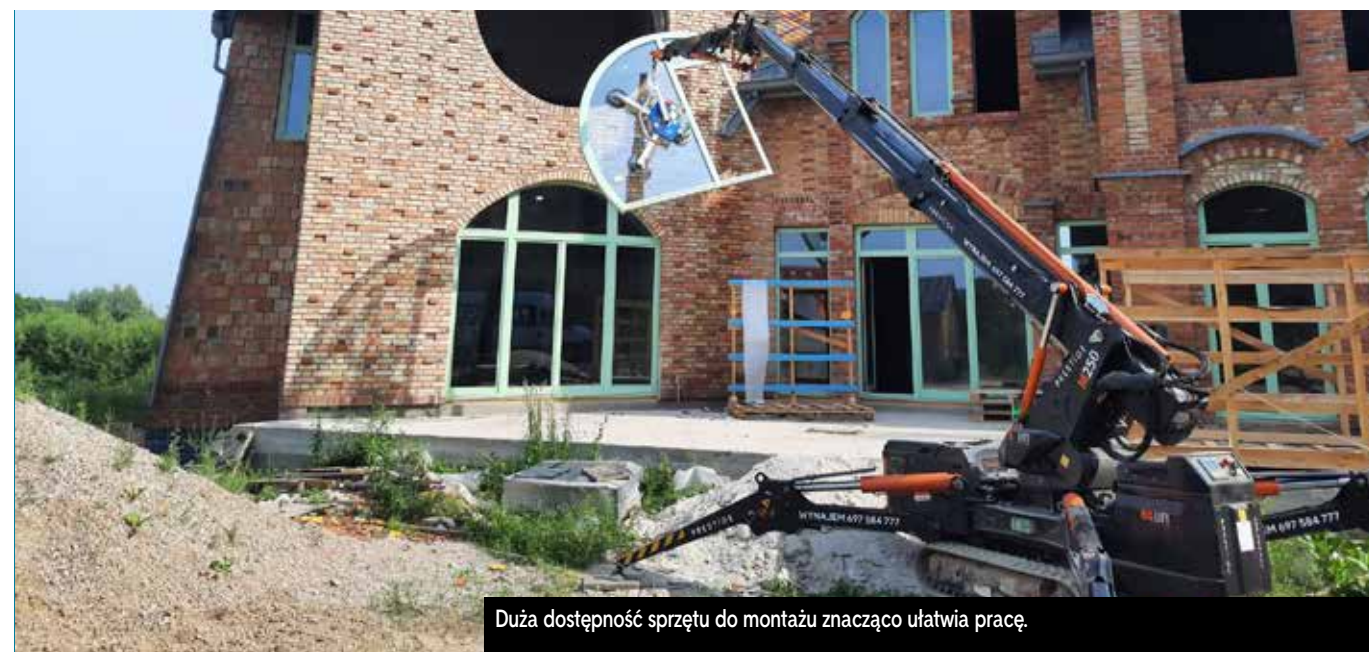
Dzisiaj niemal w każdym nowo budowanym domu występują duże okna – do ich montażu zawsze wykorzystujemy specjalistyczny sprzęt.
