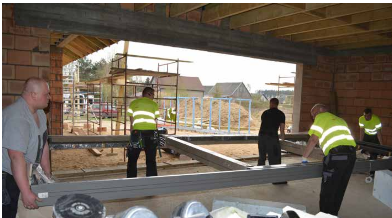
Na stałe współpracujemy z 5 ekipami montażowymi (łącznie jest to około 20 monterów), w razie potrzeby mamy sprawdzone dodatkowe ekipy, które pomagają nam, gdy nasz standardowy zespół nie jest w stanie „obrobić” wszystkich prac montażowych.
